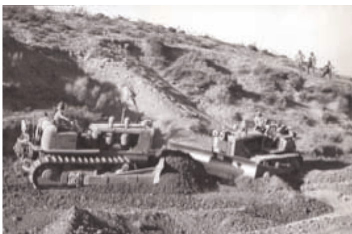
L'Armée en protection des travaux (photo Alain PICAUD).
