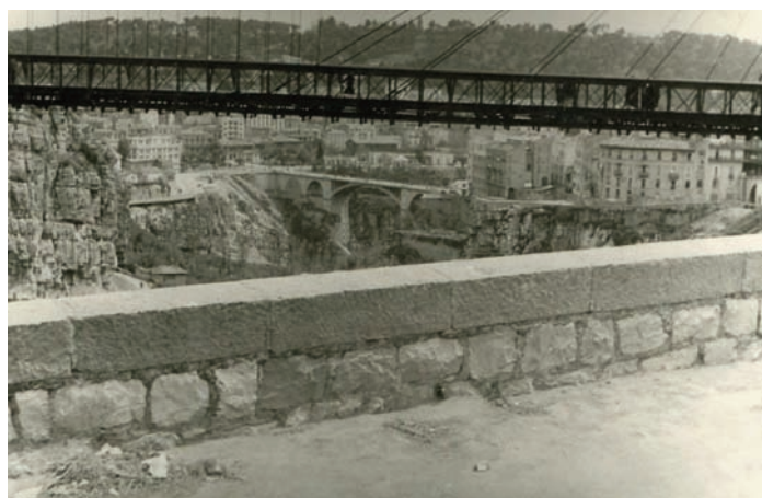
Vue sur le pont Sidi m'cid.
